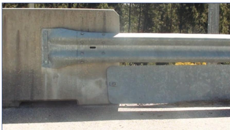
Figura 18. Transição entre a barreira semi-flexível e a barreira rígida, na via de Ligação do Nó.
