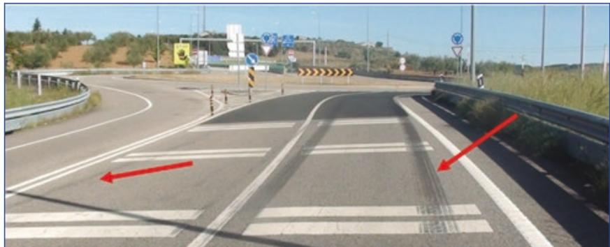
Figura 22. Várias marcas de travagem no pavimento, na zona que antecede a rotunda.
