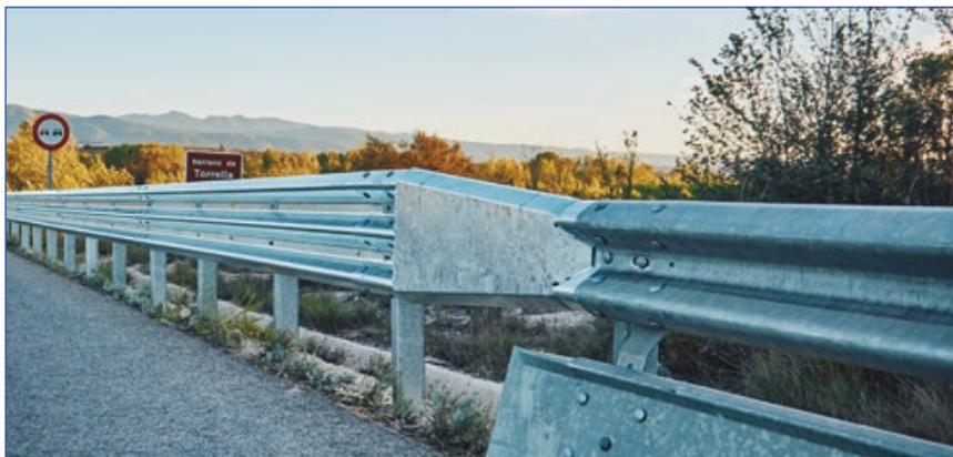
Foto 4. Ejemplo de transición entre barreras flexibles tipo bionda y trionda evaluada según la Norma NF058<sup>(VIII)</sup>.
