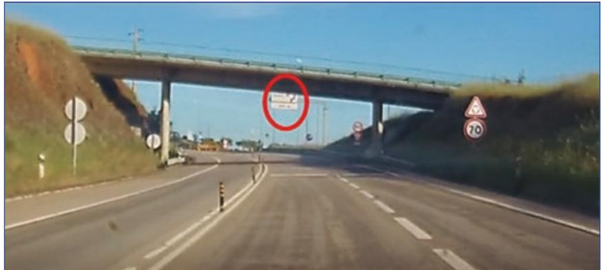
Figura 21. Painel de Pré-Aviso Gráfico (PAG) obstruído pela Passagem Superior.
