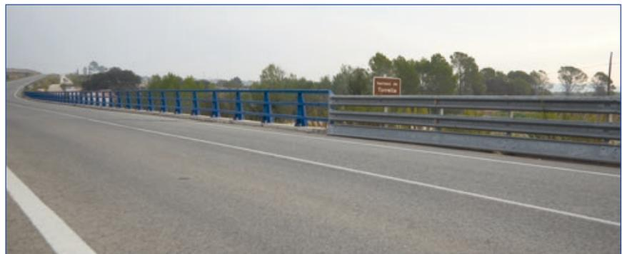
**Fotos 1 y 2.** Arriba (Foto 1), el detalle constructivo habitual en ensayos tipificados en la UNE-EN 1317-2:2011<sup>(9)</sup>, en laboratorio acreditado, de un sistema de contención de vehículos de nivel H2. Abajo (Foto 2), el mismo sistema instalado en obra siguiendo el detalle constructivo.
